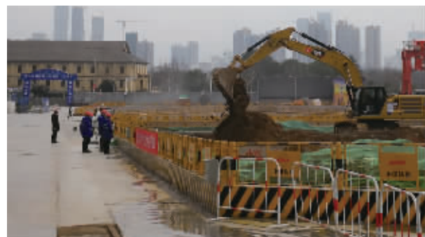
2月8日，长沙湘雅路过江通道项目复工。 通讯员供图
