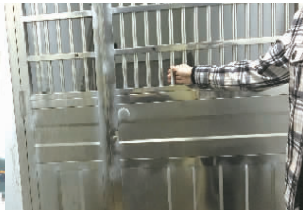
▲钰龙天下综合二楼一期30楼至29楼消防通道有一道不锈钢门。 记者 张洋银 摄
