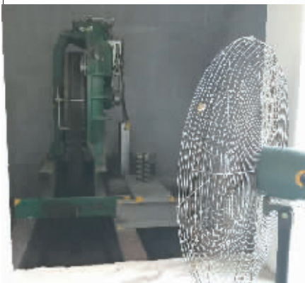
▼11月20日,物业公司组织人员抢修电梯。
