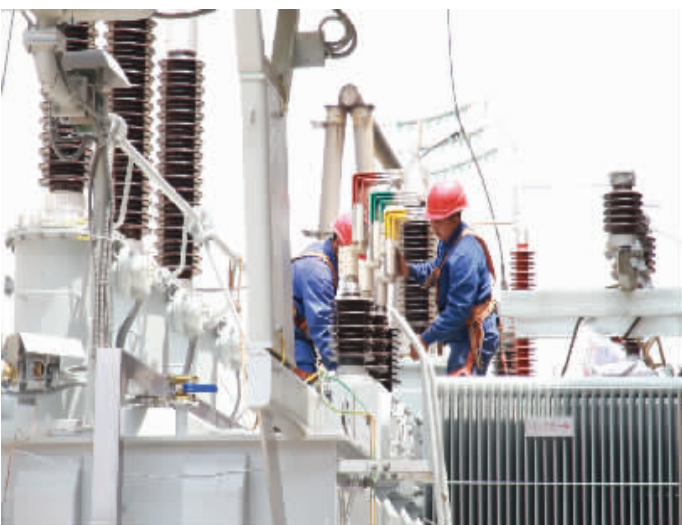
电网建设者正在安装新投运的变压器桩头。
