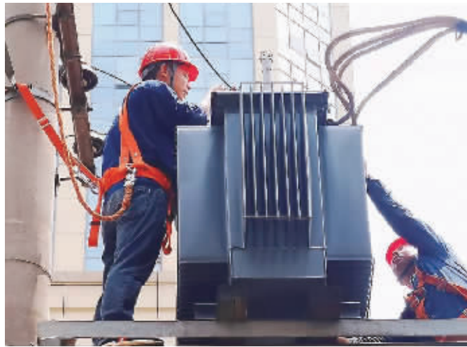
日前,长沙供电公司工作人员冒着酷暑进行电力改造。通讯员 供图
