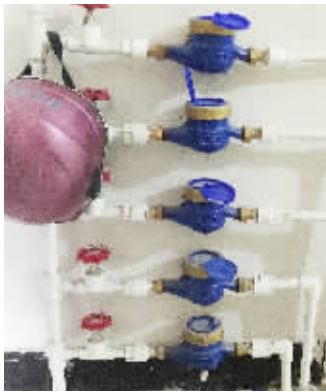
▲三室一厅被隔成5个单间后，过道里多了5个被改装后的水表。
