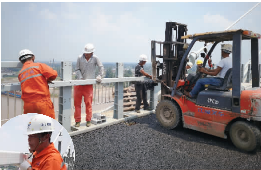
8月6日,南益高速南洞庭大桥上,孙钱和工友们正顶着烈日在安装防撞护栏。 记者 潘显璇 摄
