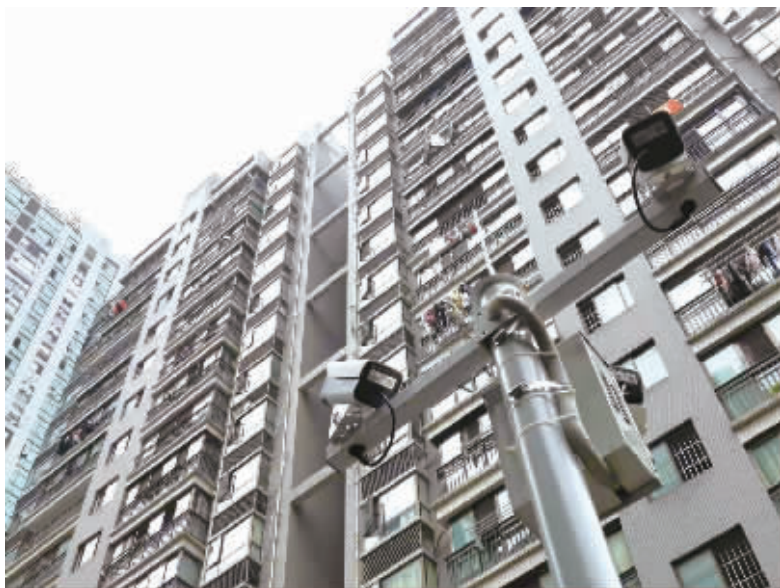
株洲天元区明峰银座小区安装了朝天监控,专门防止高空坠物。记者 杨洁规 摄
