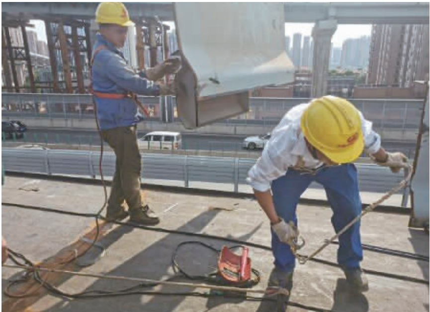
7月31日，湘府路快速化改造项目施工现场，钢结构技师在进行防撞护栏的安装。记者 石芳宇 摄
