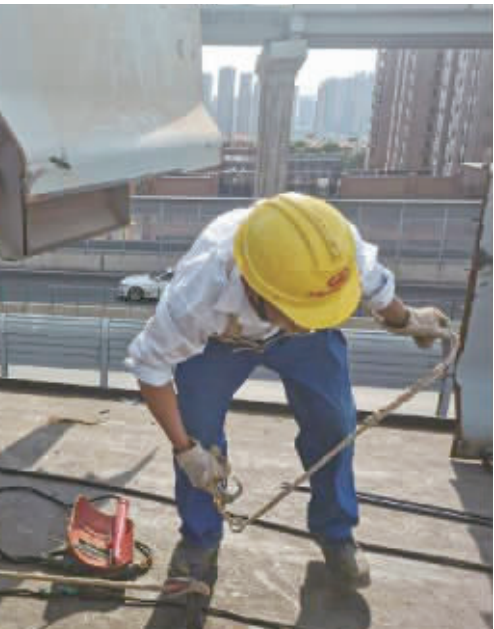
7月31日，湘府路快速化改造项目施工现场，钢结构技师在进行防撞护栏的安装。记者 石芳宇 摄
