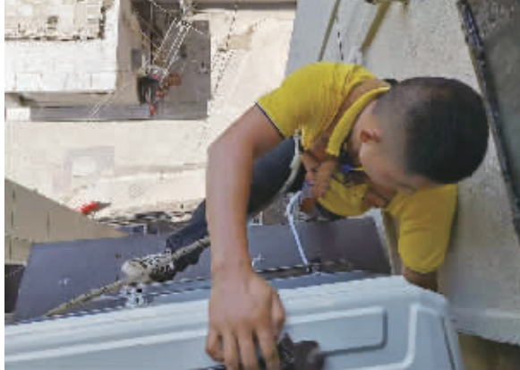
7月30日，空调安装工人孙长安正在安装空调外机。 记者 胡锐 摄
