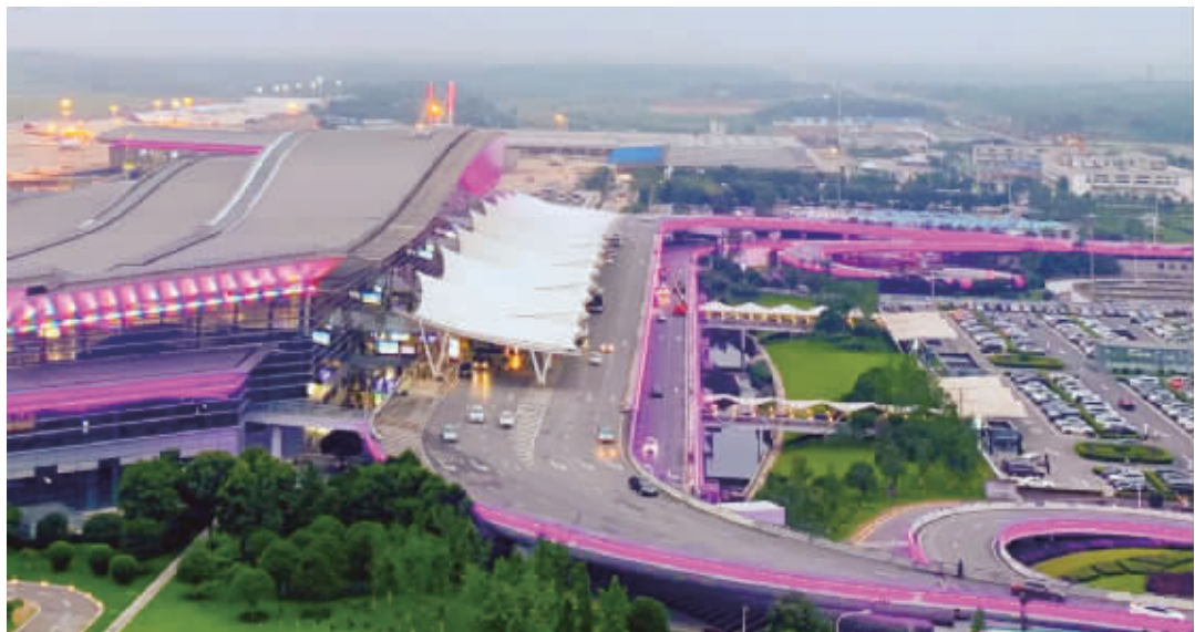
为迎接首届中非经贸博览会,充分展现湖南窗口形象,长沙机场夜景照明升级改造于6月25日正式全面投入使用。 记者 和婷婷 摄
