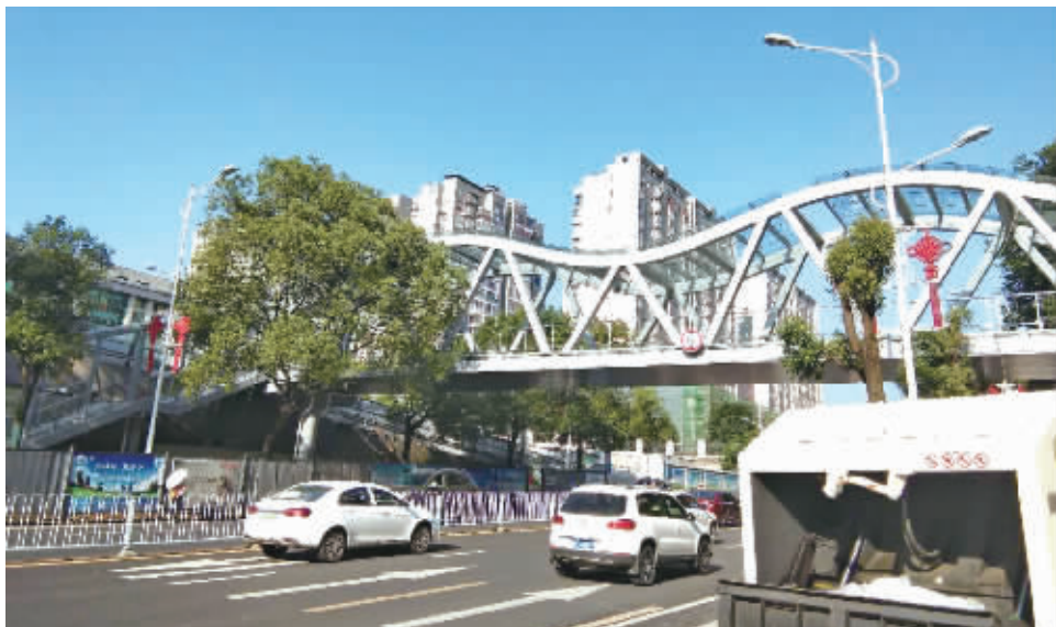
香樟路上的人行天桥立体过街设施月底将开放。 通讯员 供图
