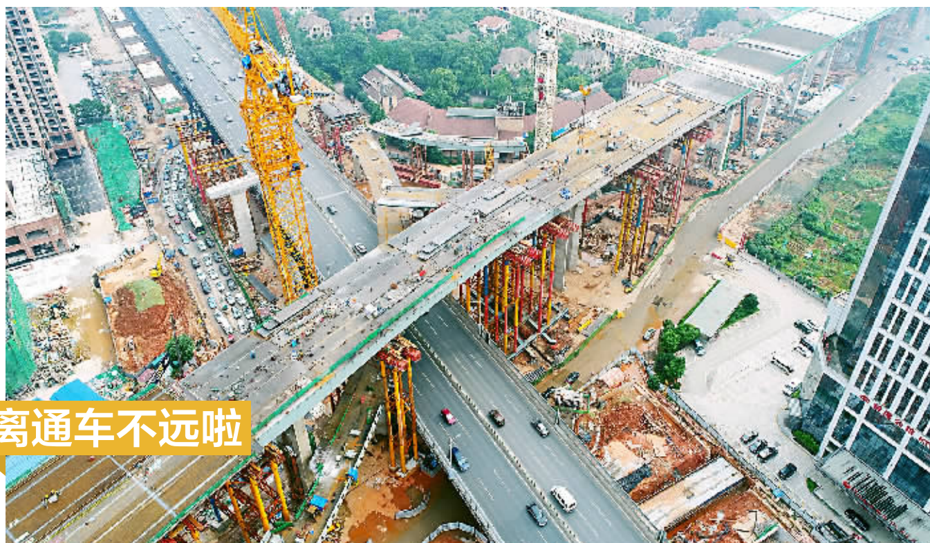
5月22日，长沙湘府路快速化改造工程跨万家丽路高架主线桥完成最后一块钢箱梁吊装施工，湘府路与万家丽路全互通立交主线合龙，标志着湘府路快速化改造工程京港澳高速以西段主线贯通。湘府路快速化改造工程全线预计9月底达到通车条件。 文/记者 陈月红 图/记者 徐行
