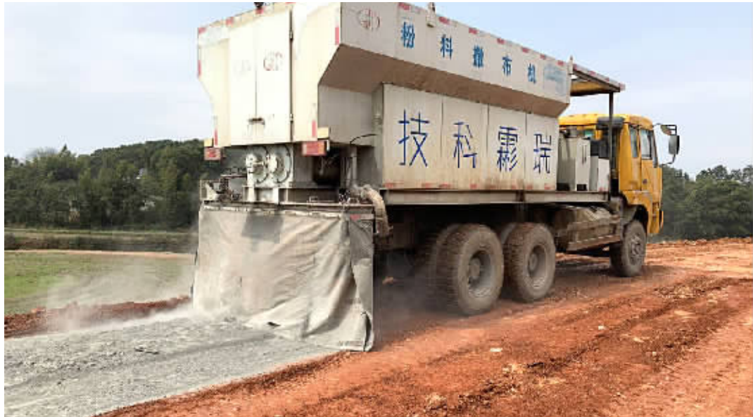
3月26日,在长益扩容工程所涉X077改线工程现场,记者看到利用“特种水泥”施工,省料省时又环保。 记者 和婷婷 通讯员 尹建军 黄金美 摄
