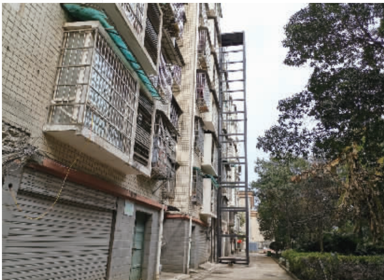
3月20日,株洲天元区,园丁小区里正在建设的电梯。杨洁规 摄
