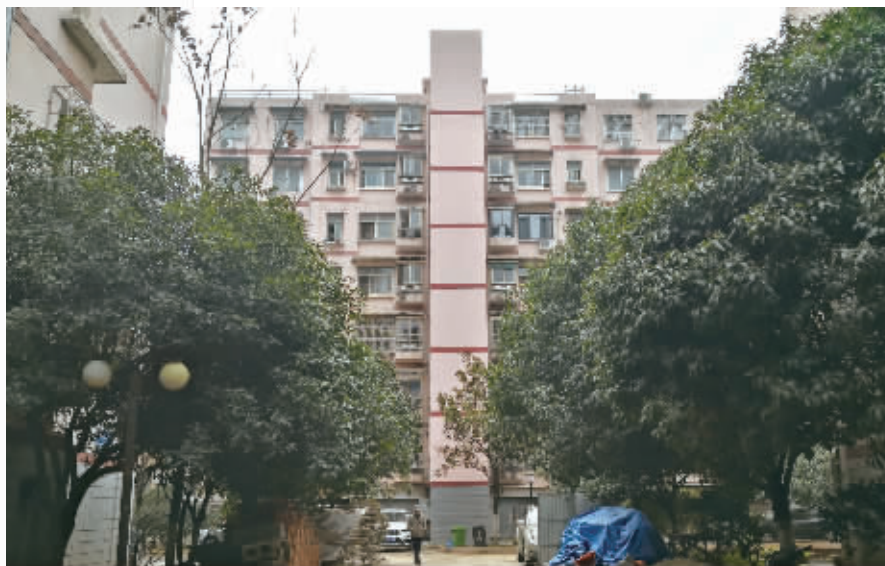
3月14日,长沙晚报宿舍小区内,部分楼栋已经加装上了电梯,电梯外墙与楼栋墙面颜色一致。
