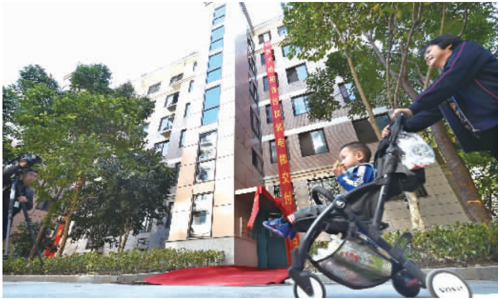
在浙江杭州江干区丁兰街道大唐苑小区内,居民从加装了电梯的居民楼前走过。 新华社 图
