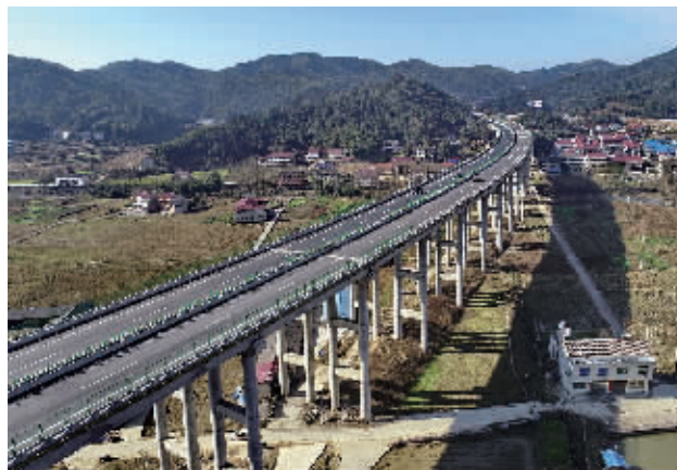
2018年12月18日,马安(马迹塘-安化)高速安化县境内的王家坪善溪大桥。当天,历经3年建设的马安高速公路正式通车试运营,湘中经济社会发展迈入互联互通的全高速时代。 记者 童迪 摄
