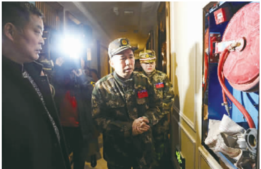
12月24日,长沙市消防支队正在检查灭火器材是否合格。 记者 张洋银 摄
