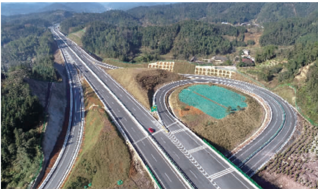
12月18日,马安高速公路正式通车试运营。 记者 童迪 摄
