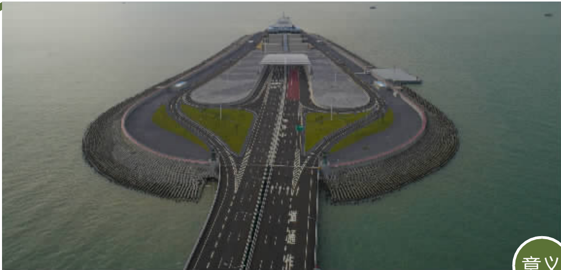
港珠澳大桥香港段人工岛。(新华社图, 10月13日摄)
