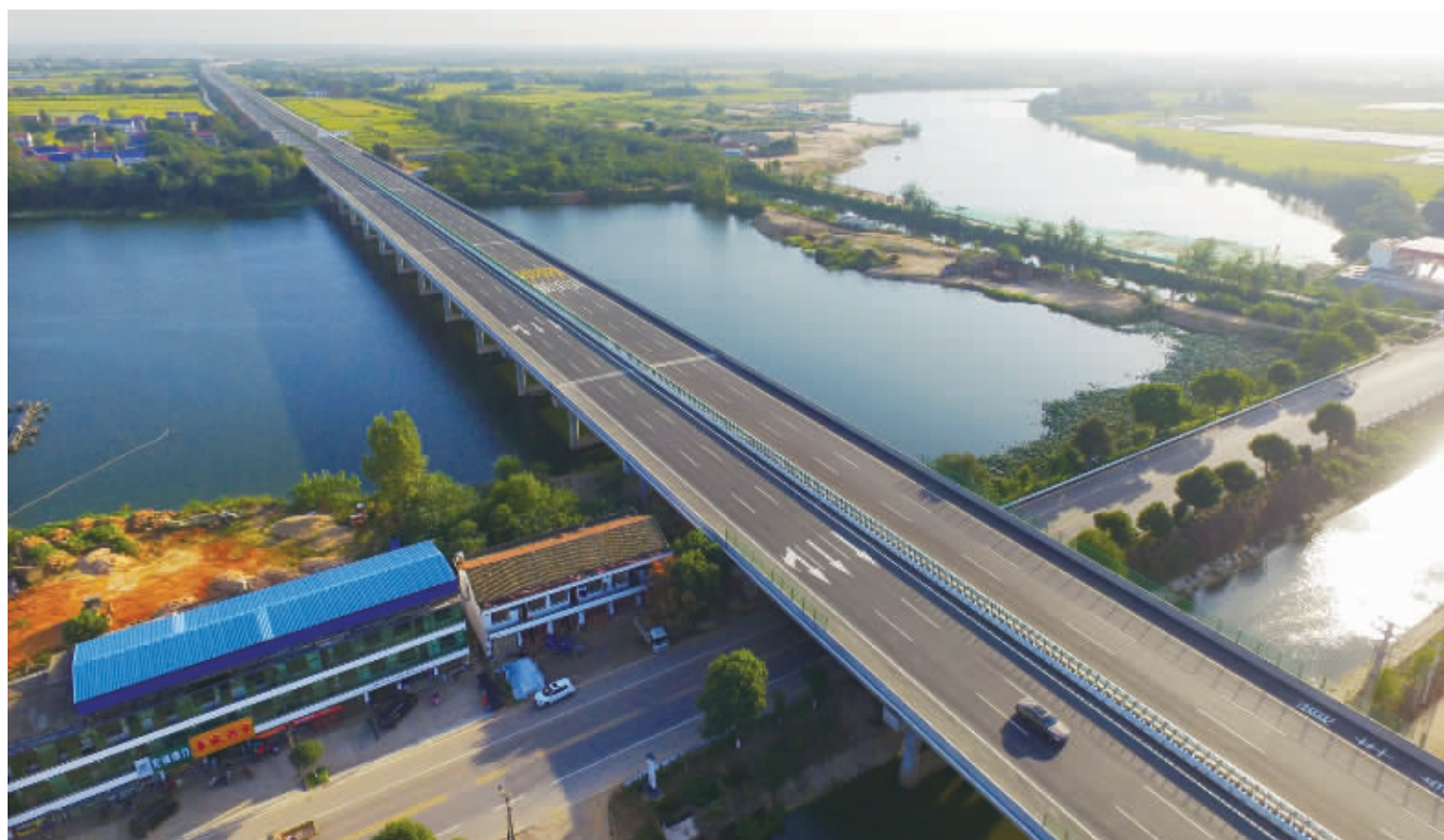
9月29日下午,岳望高速(岳阳市昆山至长沙市望城区茶亭镇高速公路)岳阳市屈原管理区段,机动车在刚刚放开交通的道路上行驶。当天16时许,岳望高速通车试运营,标志着我省目前唯一的六车道南北高速通道——京港澳复线湖南段全线贯通。该路全长101.6公里,设计时速120公里。
