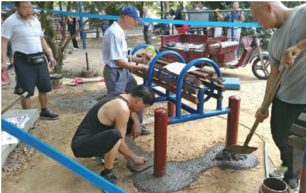
9月16日,湖南烈士公园内一处空地正在安装维修市民众筹的健身器材。 王国光 摄
