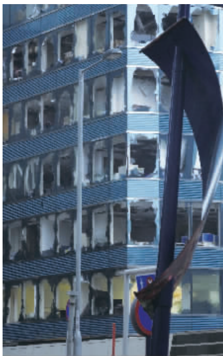
9月16日,位于香港九龙半岛红磡海滨的一座写字楼,窗户玻璃破碎严重。
