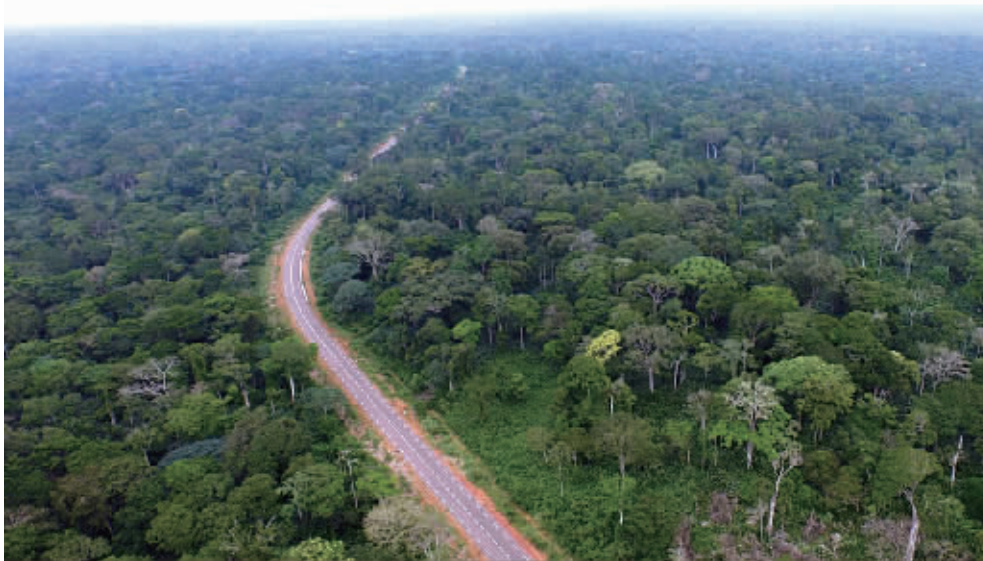
中建五局建设的刚果(布)国家1号公路项目。
