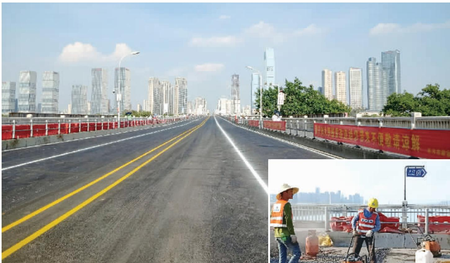
8月19日,记者在施工现场看到,橘子洲大桥行车道已完成沥青摊铺,并已划好交通标识,焕然一新,一眼望去桥面显得很平整。工人正在进行无缝伸缩缝施工(小图)。
