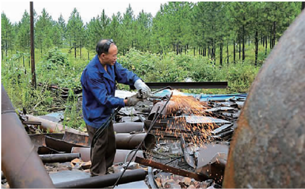
永州市零陵区46家小高炉拆除现场。 通讯员 供图
