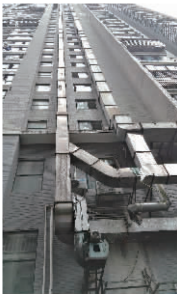
长沙县时代星城小区外墙外挂靠着百米烟道。 记者 张洋银 摄
