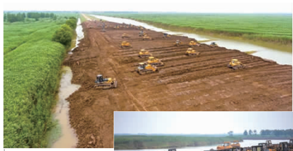
连日来，益阳沅江市集中开展南洞庭湖下塞湖矮围拆除专项整治行动，图为施工现场景象。 益阳广电 供图
