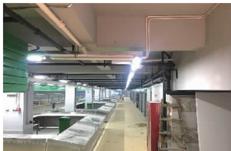
6月4日，咸嘉新村悦峰园小区生鲜市场已装修完善。 记者 张洋银 摄
