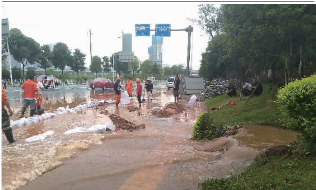
5月29日凌晨4时左右,长沙市浏阳河大道的嘉雨北路口,一根污水压力管突然爆裂。当日上午9时,施工人员正通过沙袋围堵的方式,将污水引流到涵水处两侧的其他下水管道内。 记者 李成辉 摄影报道
