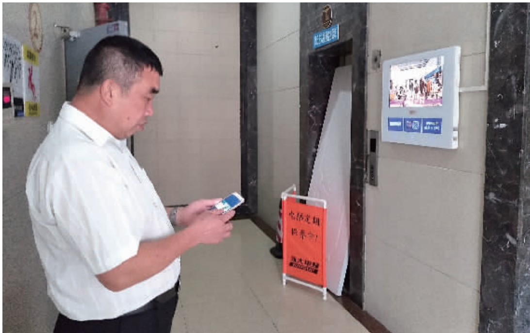
5月23日上午，长沙市天心区万芙锦城小区5号楼1单元2楼电梯间，物业人员在被损坏的电梯前查看。记者 杨昱 摄
