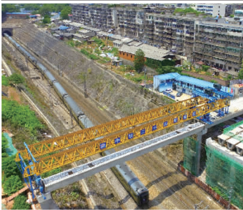
5月16日,中铁二十五局集团长沙市曙光路(车站路-雅塘冲路)项目部施工现场,一趟列车从已安装好的跨京广铁路桥首梁下穿过。当天上午,一个40米长、重150吨的箱梁成功架设在项目跨京广铁路辅道桥2#墩上并完成安装。标志着首梁架设成功,该项目正式进入跨既有架架设施工阶段。
