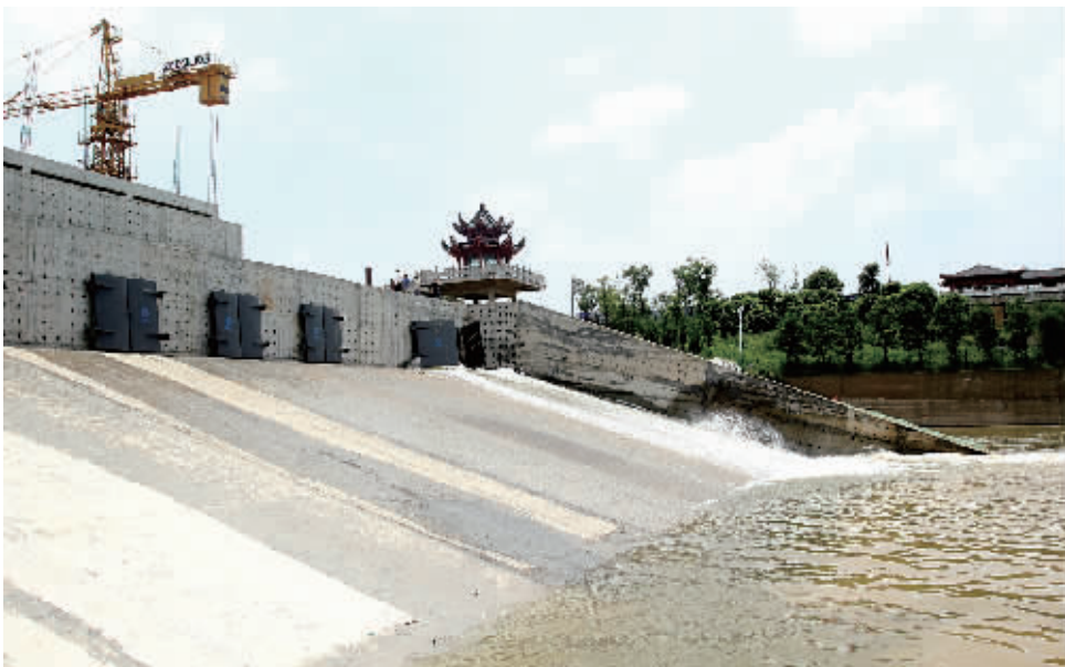
长沙望城区的高沙脊泵站电排通水成功,这也意味着,汛期沱水河口水位上涨,该泵站便可通过电排进行排水,增强防洪泄洪能力。 通讯员 毛伟冬 摄
