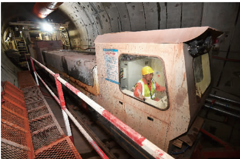
5月9日,长沙地铁5号线马栏山站至月湖公园北站区间右线施工现场,电瓶车牵引渣土车缓缓从作业区驶出。 记者 田超 通讯员 雷密红 摄
