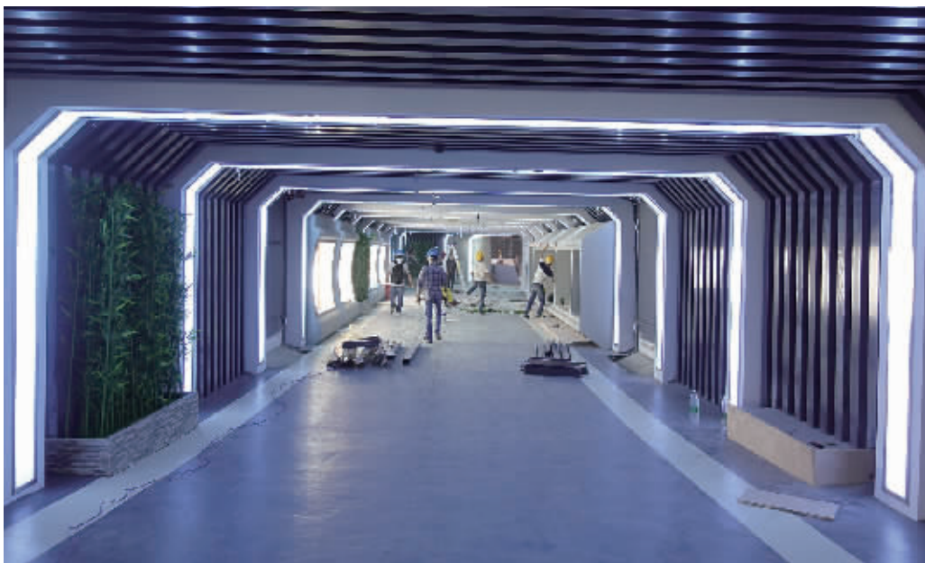
长沙变化率信息技术有限公司工作人员在长沙城市综合管廊展示厅施工。
