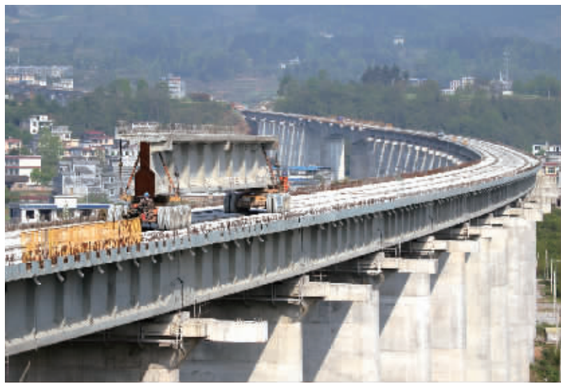
酉水河特大桥 T梁架设完成
