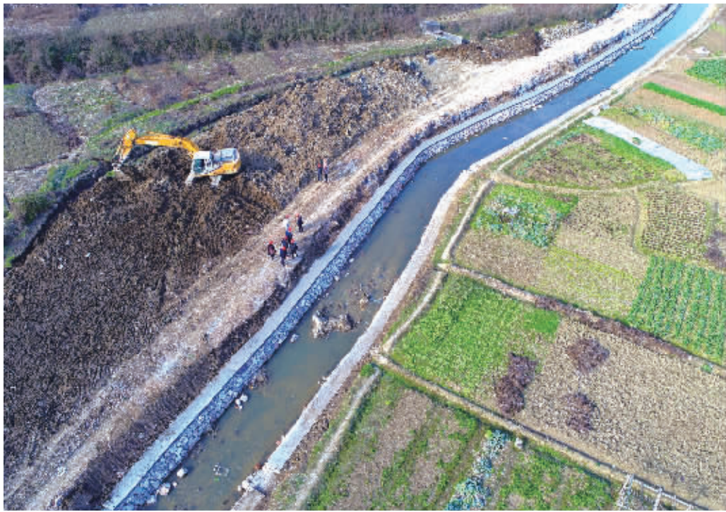
2月6日，邵阳市双清区龙须塘老工业区，洋溪沟河段正在进行清淤疏浚。记者 徐行 摄
