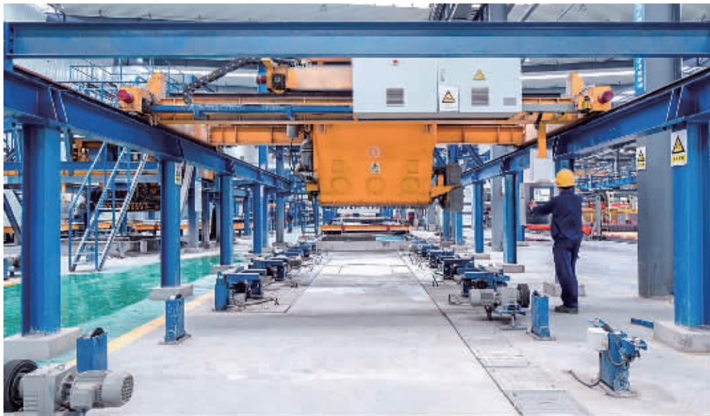
2月6日,中民筑友装配式成套科技住宅制造基地,技术人员正在生产线上作业。 记者 卜岚 摄
