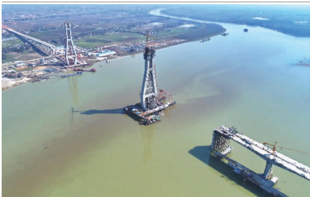
2月5日,沅江市草尾镇,南益高速南洞庭大桥162米高的索塔,预计3月份封顶。南洞庭大桥是南益(南县-益阳)高速重点控制性工程,主跨450米,塔高162米,是我省目前在建最大跨径、最大桩长的斜拉桥。
