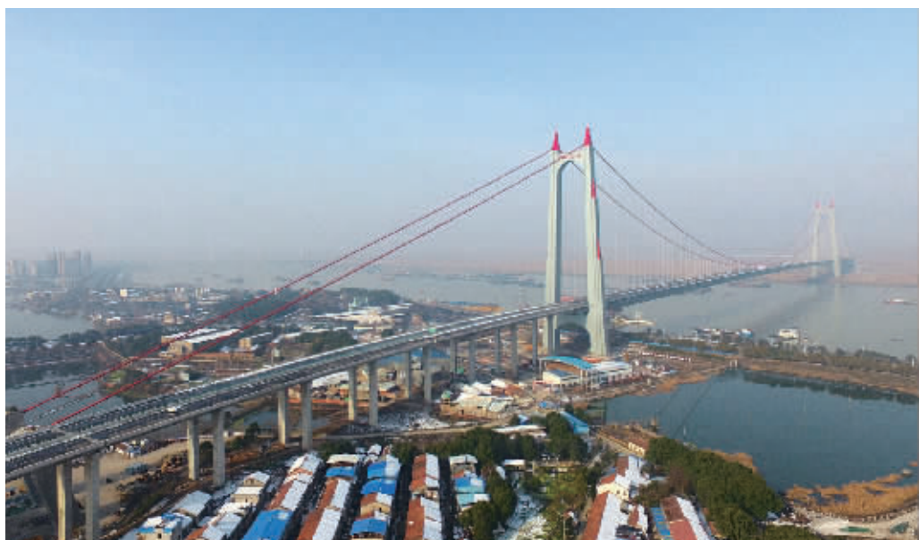
2月1日拍摄的杭瑞高速洞庭湖大桥。当日,杭(杭州)瑞(瑞丽)高速洞庭湖大桥建成通车,标志着杭瑞高速湖南段全线贯通。据介绍,该大桥主跨长1480米,在钢桁加劲梁悬索桥中排名国内第一、世界第二。 新华社 图
