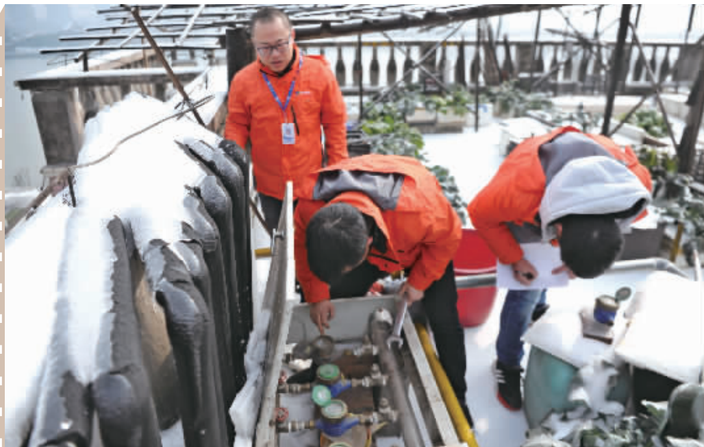
1月29日,长沙市岳麓区溁湾镇航空母舰小区,工作人员在楼顶抢修冻裂的水表。受冰雪天气影响,该小区40多块室外水表被冻裂,供水公司工作人员迅速前往更换水表,恢复了小区居民供水。 见习记者 傅聪 摄
