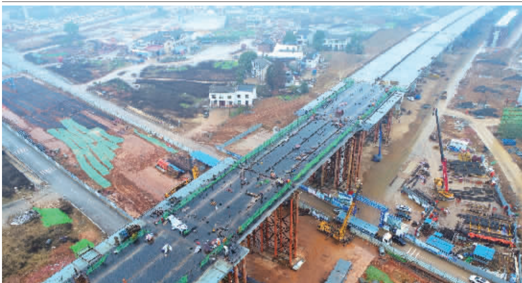
1月24日,长沙市红旗路主线高架上跨湘府路最后一块主体钢箱梁吊装到位,标志着湘府路快速化改造工程全线首座跨线桥顺利合龙,进入拼装焊接作业阶段。 记者 徐行 摄
