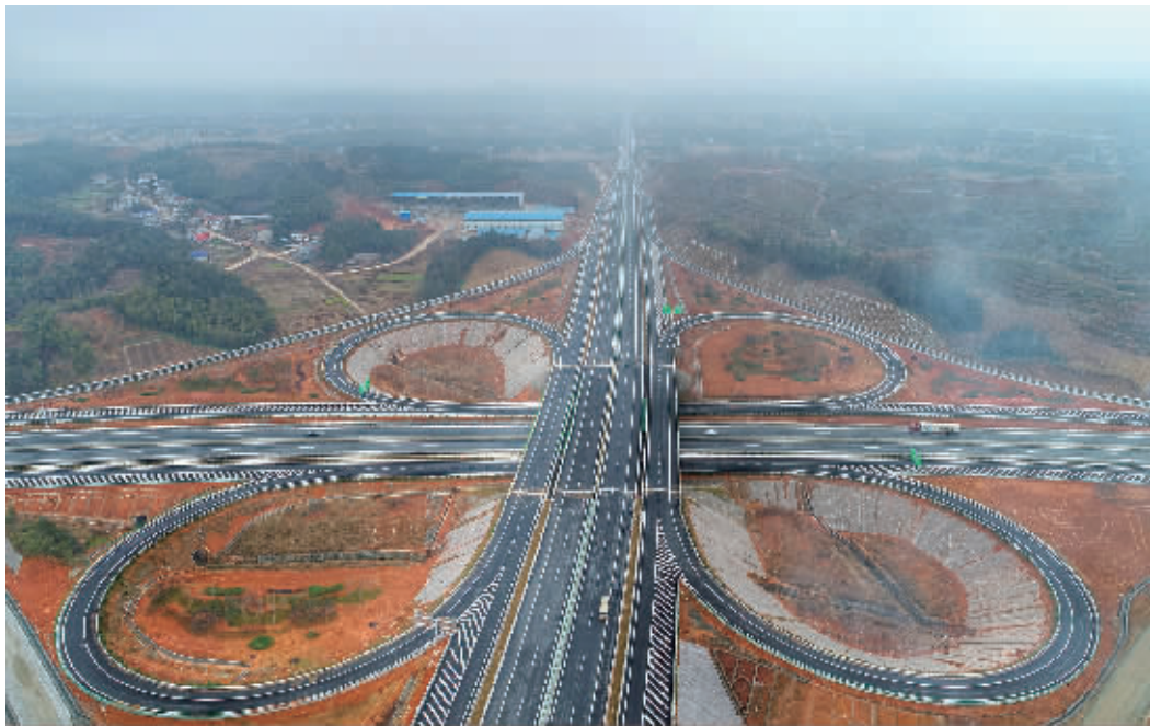
1月22日,桃江县境内的益马(益阳至马迹塘)高速与二广高速互通。该高速公路已基本完工,将于春节前通车。
