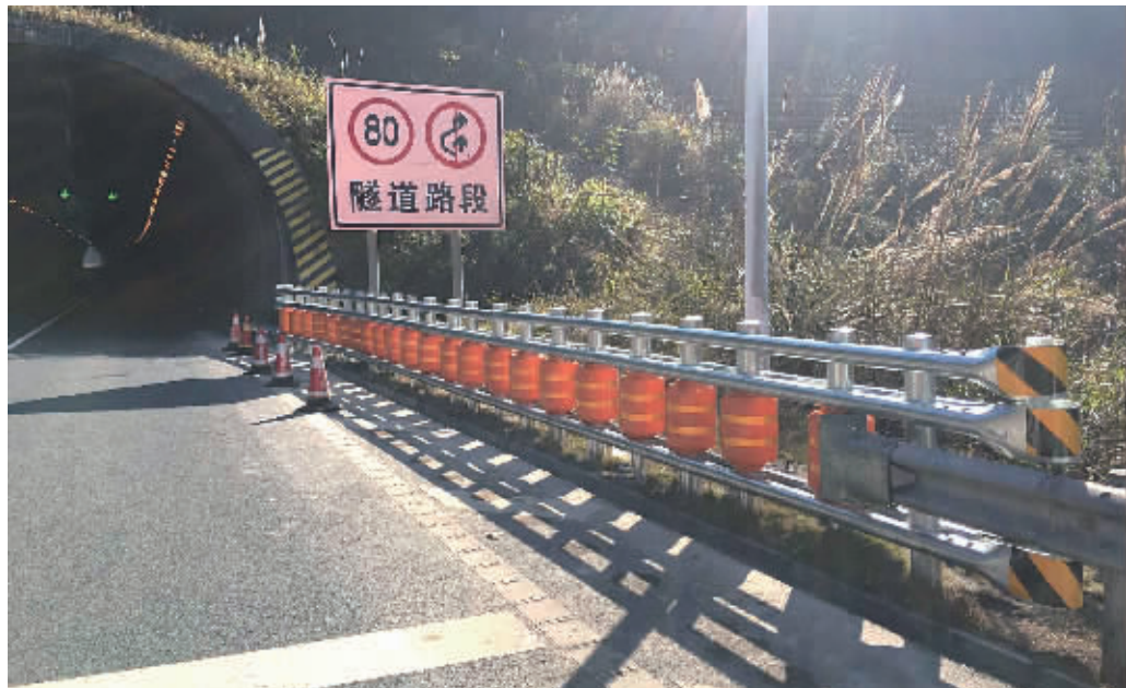
株洲高速部分隧道入口处装上了“旋转式防撞桶”。 记者 潘显璇 摄
