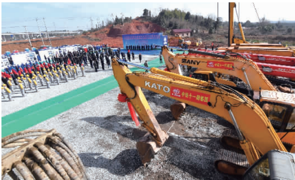
1月11日上午,长沙国家经济开发区内机场高速与长株高速交会处东南侧,中国首条智能化中低速磁浮试验线——长沙中低速磁浮试验线破土动工。 记者 田超 摄
