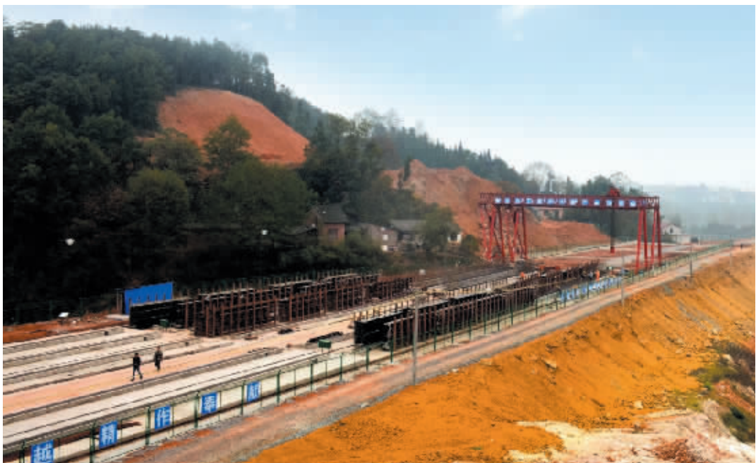
正在建设中的娄底大道新化段
