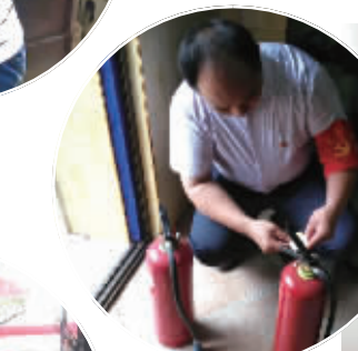
青竹湖 街道党员志 愿者检查消 防设施。
