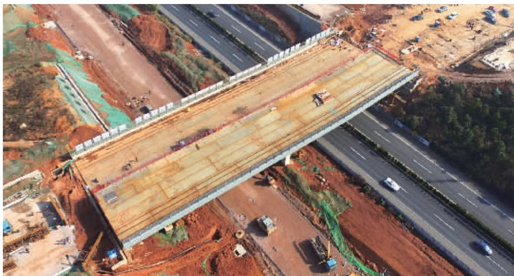
12月19日上午，湖南湘江新区智能系统测试区，中建五局施工人员将长潭西高速公路跨线桥南幅钢箱梁顶推到位。 记者 田超 通讯员 方茜茜 摄
