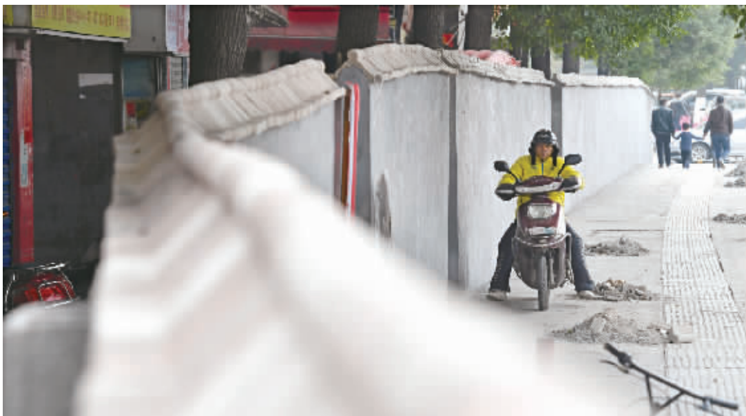
12月6日上午,长沙市湘江中路,行人从西文庙坪棚户区围挡边经过。2日开始,西文庙坪周边地块棚户区改造项目一期正式启动围挡。该项目一期北至人民西路,南至古潭街,西至湘江路,东至古潭街,将打造长沙近代民俗风情建筑群,以展示古城风貌。 记者田超 摄
