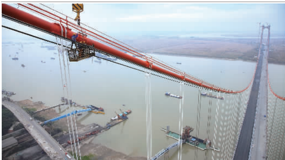
11月27日,岳阳市东洞庭湖七里山水域200米上空的杭瑞高速洞庭湖大桥施工现场,湖南路桥工人在进行猫道拆除作业,标志着该大桥上构工程施工已近扫尾阶段。大桥预计2018年春节前建成通车。
